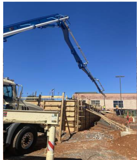
Pouring foundation walls
